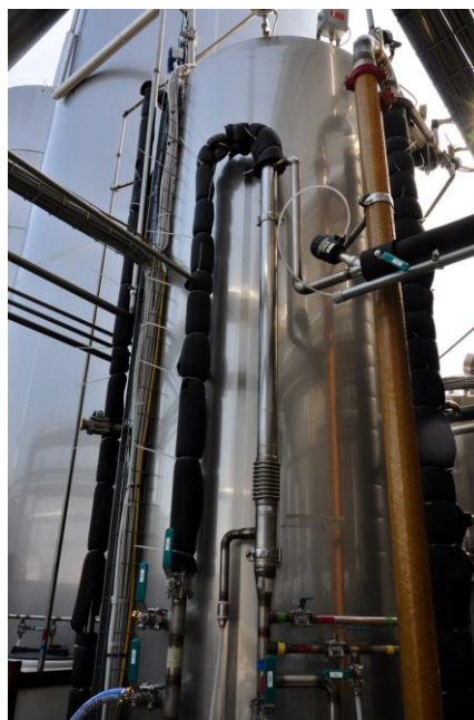
Figura 3: Il bioreattore anaerobico a membrana (membrana in configurazione esterna)
