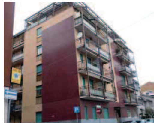
Il condominio a Cinisello Balsamo dove è stata installata la Pelletfire Plus di KWB è uno dei 10 impianti a pellet realizzati da Carbotermo a Milano e in provincia con le medesime modalità
